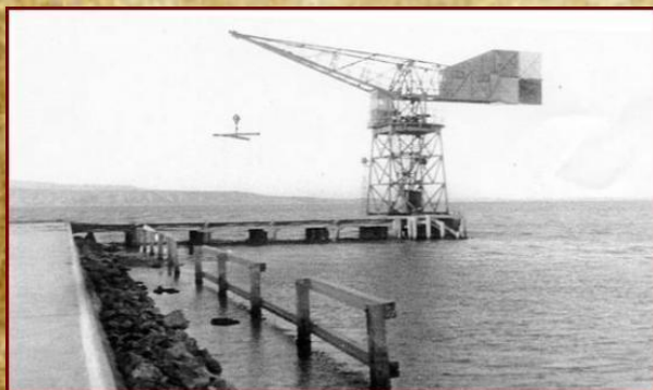
La jetée de 130 m et la grue de mise à l'eau.
